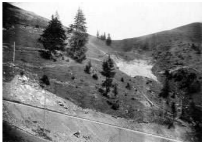
Bau an der Schafbergbahn 1892
