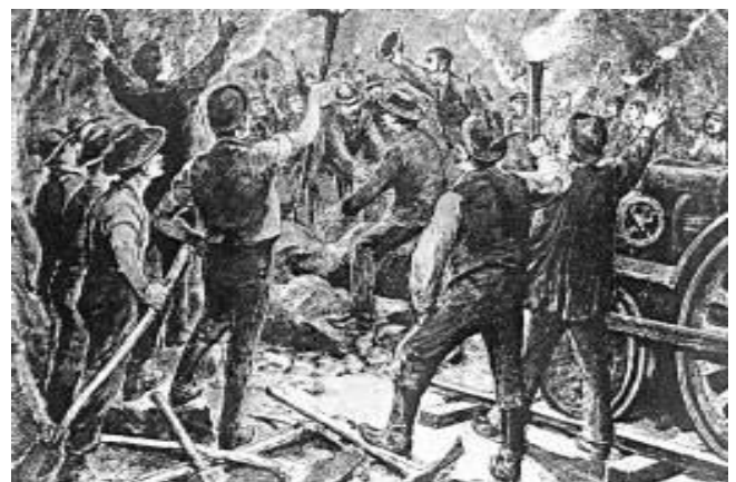
SKGLB: Durchstich des Eibenbergtunnels bei Strobl, 1893
