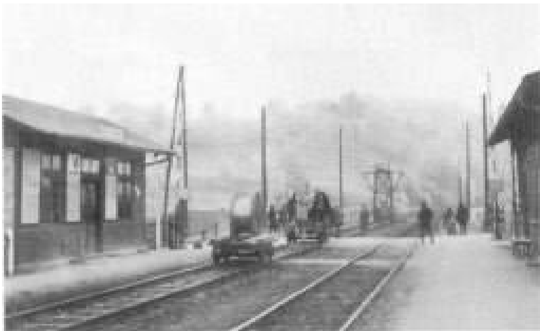
Eines der in den 30er Jahren vorgenommenen Elektrifizierungsprojekte im Bereich des Bahnhofes Lambach.
