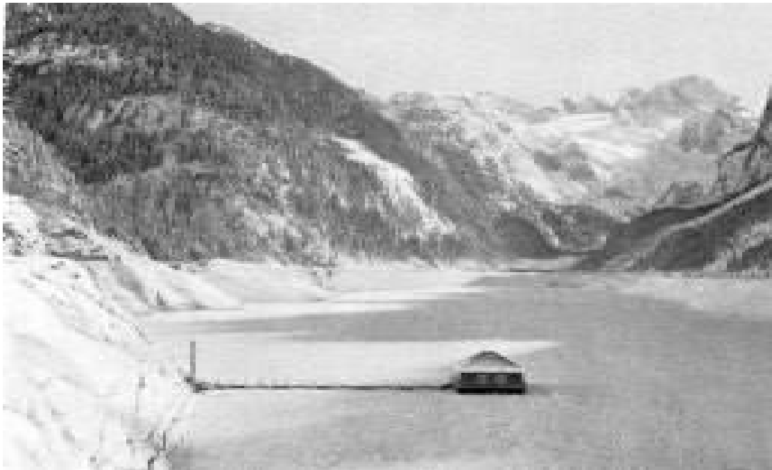
Die Schwimmeranlage mit den Speicherentnahmepumpen am Gosausee, 1929
