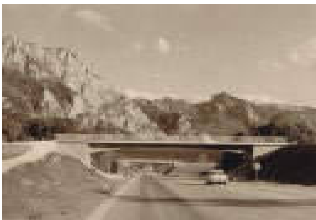
Brücken Umfahrung Gmunden-West mit Gebirgs-panoramablick, 1967
