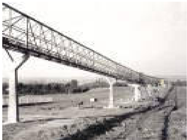
Die neue Kohle-Förderbrücke zum Wärmekraftwerk „Riedersbach I“, 1967
