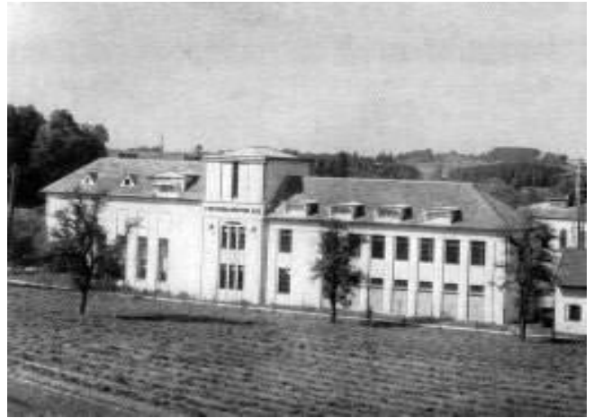
Das Umspannwerk in Gmunden, von 1924 bis 1926 errichtet
