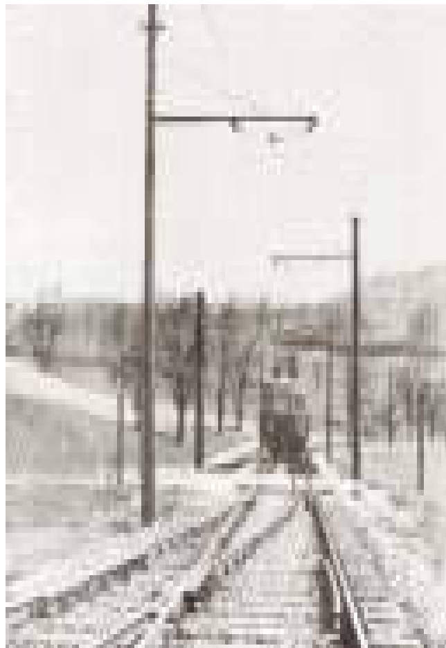
Die von 1957 bis 1958 von vier auf drei Schienen rückgebaute Péagestrecke bei Gmunden auf der Lokalbahn Gmunden-Vorchdorf mit dem 1957 äußerlich völlig modernisierten Triebwagen aus 1912
