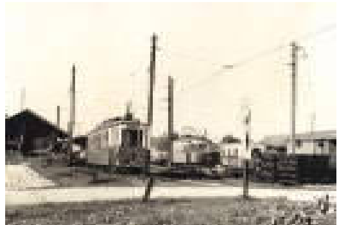
Die Vorchdorfer Bahn-Zentral-Werkstätten-Anlage mit Fahrzeugen 1968, seit 1944/47 ausgebaut
