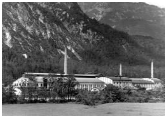
Die fertige Anlage 1924
