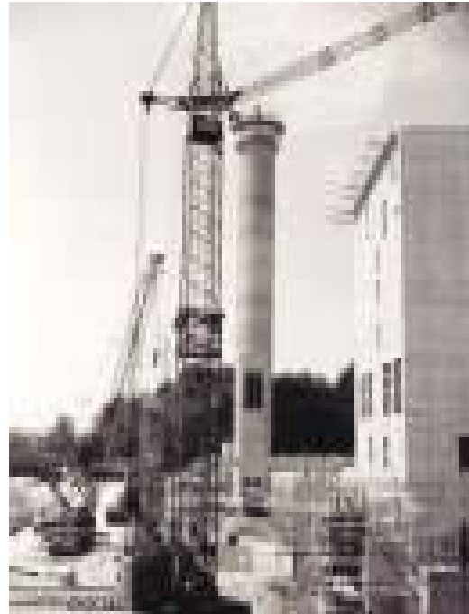
Das Wärmekraftwerk „Riedersbach I“, in Arbeitsgemeinschaft ab 1967 errichtet
