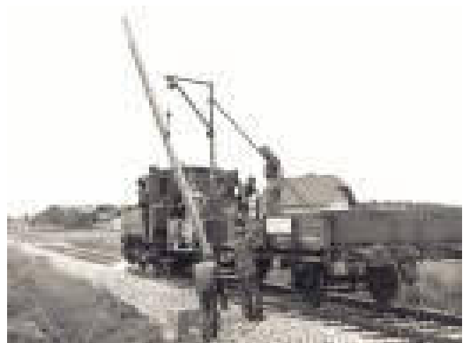
Fahrleitungs-Montage der Bahn Bürmoos-Trimmelkam, 1950
