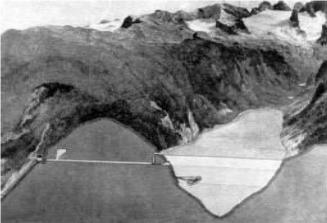
Die Schwimm-Absenkpumpenanlage zum Kraftwerk Gosau III, von 1926 bis 1929 gebaut
