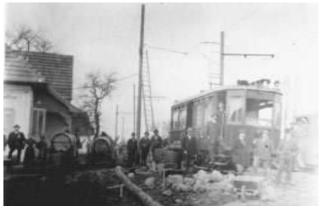
Bauarbeiten der Lokalbahn Gmunden-Vorchdorf, 1911
