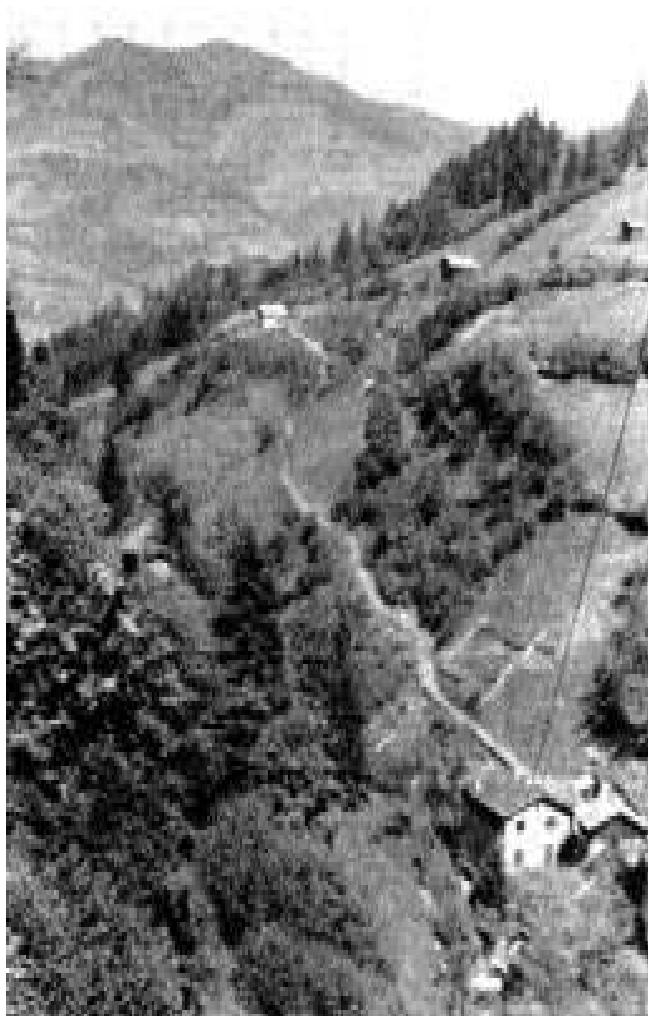
Das 1919 erworbene Kleinwasserkraftwerk Wagrain
