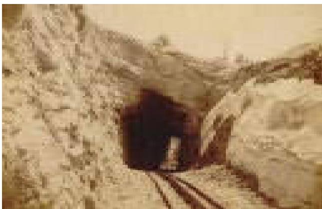
Tunnelbau bei der Salzkammergutlokalbahn, 1893
