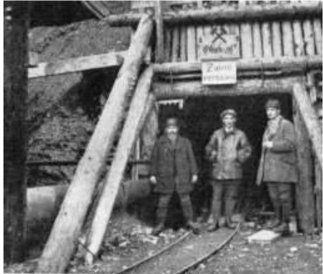
Stollenbauarbeiten in Ranna, 1925
