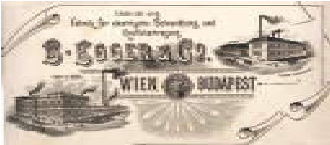
Die erste elektrische Fabrik für Beleuchtung und Kraftübertragung von Belá Egger, dem Grundausstatter der ersten Stern & Hafferlschen E-Werke, Prospekt 1895
