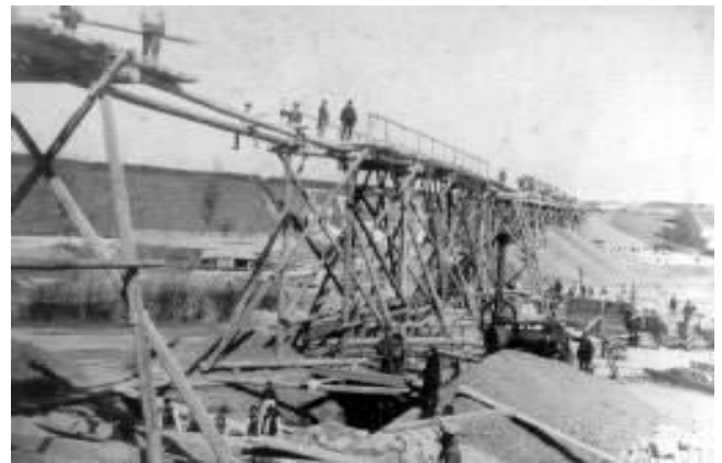
Bauarbeiten an der Dampftram bei Rodaun 1883
