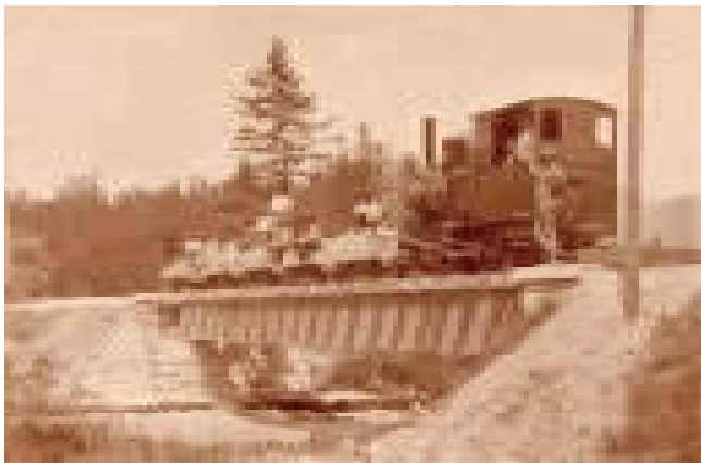
SKGLB: Brückenbau über die Ischl 1890 mit Hilfe der Lok Nr. 2
