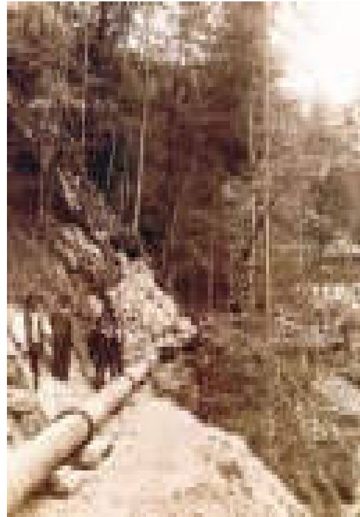
Dietlbach I, Rohrleitungsbau zum ersten Speicherkraftwerk, 1903
