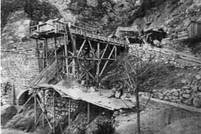
Bau der Rudolfseisenbahn bei Ebensee 1875
