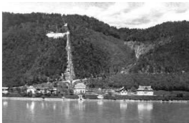
Das Wasserkraftwerk Ranna, seit 1923 gebaut
