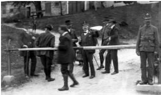
Begehung zwecks Elektrifizierung der Trasse Attnang-Stainach, 1911
