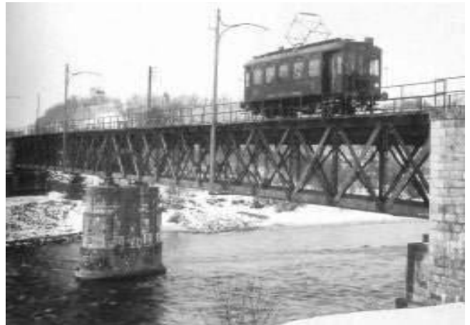
Der neue Triebwagen der <LV> überquert die Traunbrücke kurz nach Inbetriebnahme des elektrischen Betriebes, Dezember 1931
