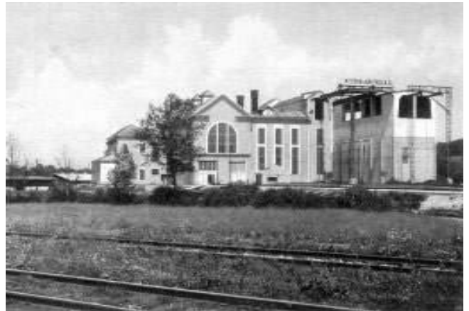
Die Dampfkraftwerksanlage Timelkam, 1926
