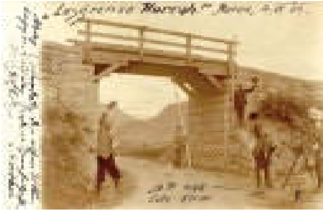
Trassierungsarbeiten bei Moena, 1904
