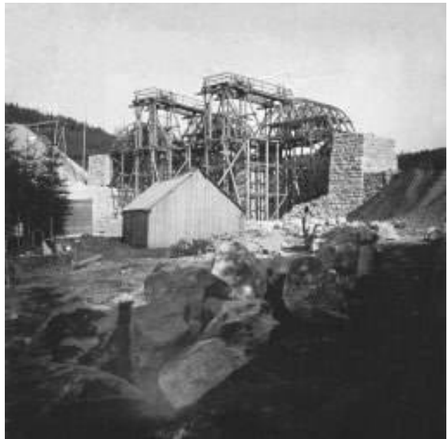
Brückenbau bei der Lokalbahn Reichenberg-Gablonz, 1886
