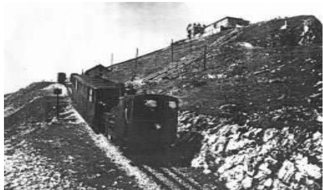
Schafbergspitze, Station und Aufzug zum Hotel
