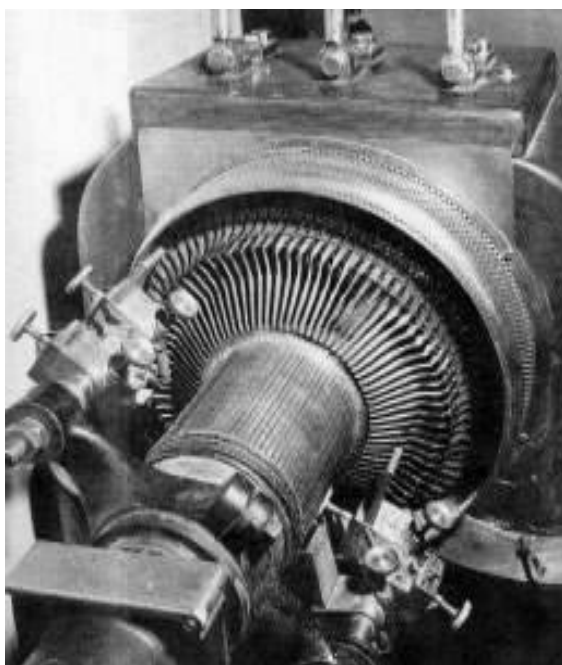
Der älteste Generator vom DKW St. Wolfgang 1893, heute in der Halle der Volksschule St. Wolfgang
